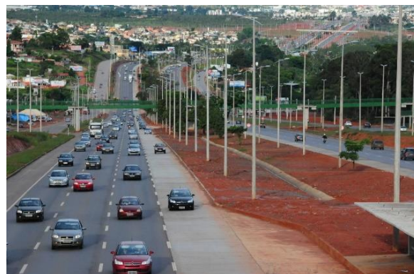
Figura 16 - EPTG - Obra concluída
