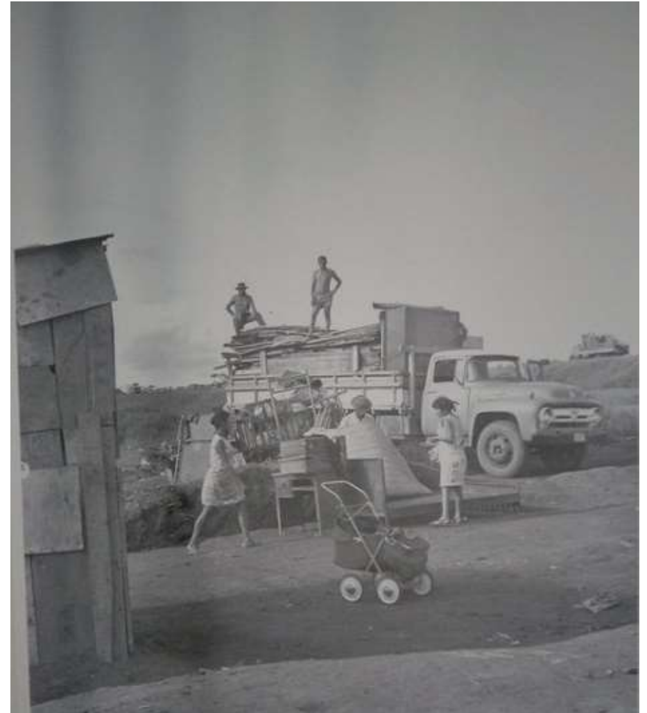
Fonte: Arquivo Público do Distrito Federal – Transferência para a Vila São José
