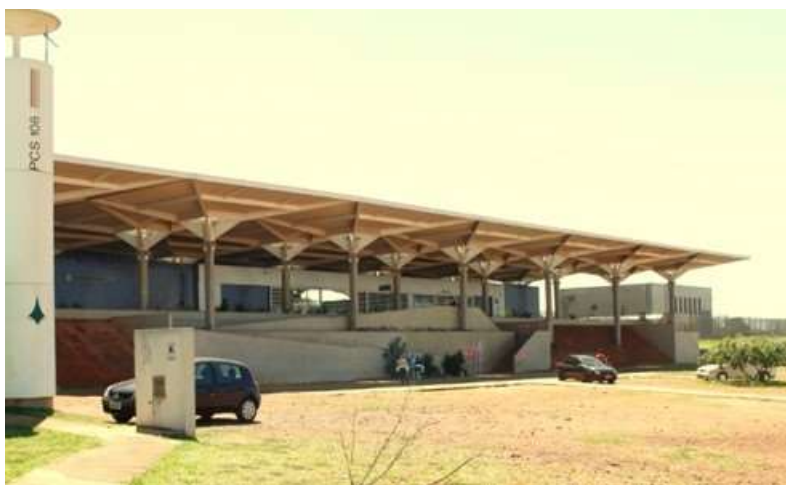
ESTAÇÃO DO METRÔ Fonte: CODEPLAN – Foto: Toninho Leite
