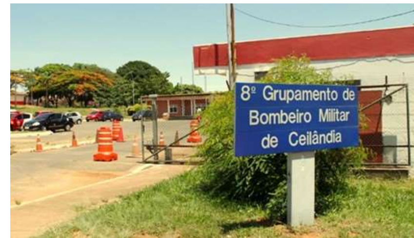
8º GRUPAMENTO DE BOMBEIRO MILITAR DE CEILÂNDIA Fonte: CODEPLAN – Foto: Toninho Leite
