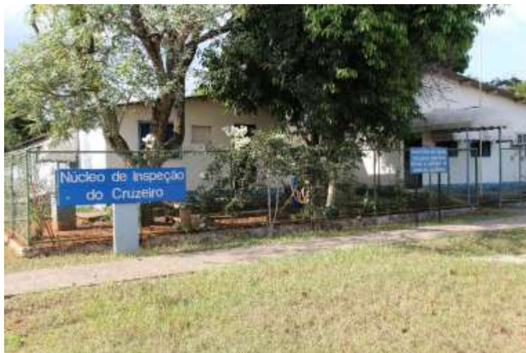
NÚCLEO DE INSPEÇÃO DO CRUZEIRO
