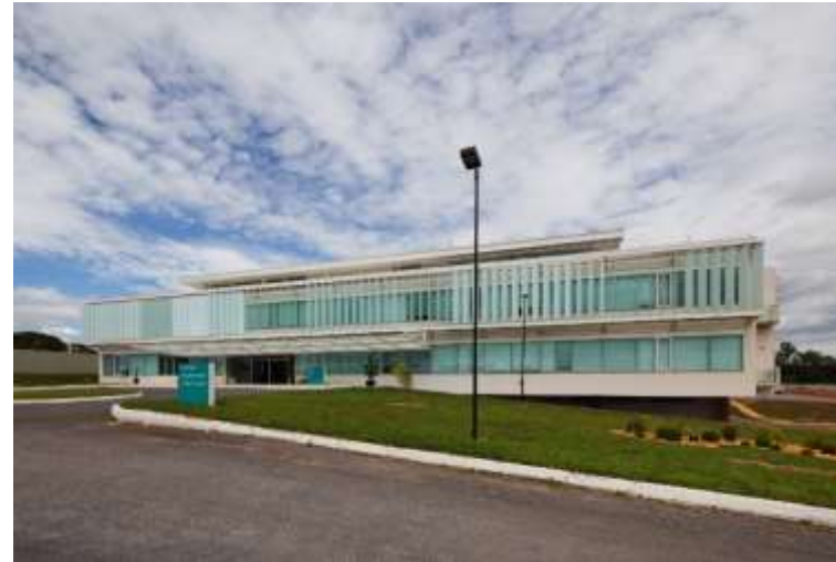
COMPLEXO CASA DA ONU Fonte: https://nacoesunidas.org/agencia/unops/
