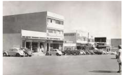
Taguatinga: comércio em alvenaria na Av. Central - foto de junho de 1971 Foto: Aldo Paviani
