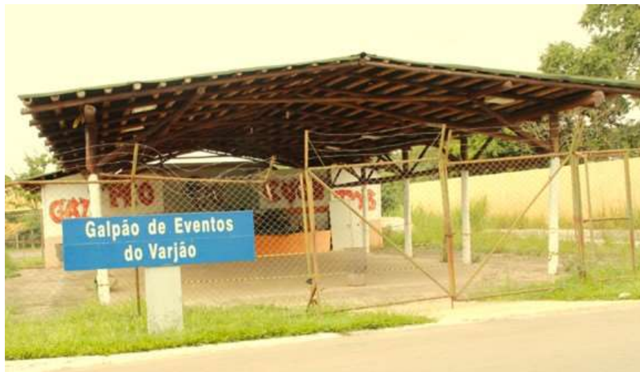
GALPÃO DE EVENTOS DO VARJÃO Fonte: Toninho Leite
