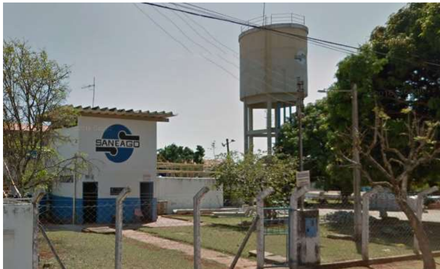
Reservatório de Água SANEAGO - Alexânia Fonte: Google Maps
