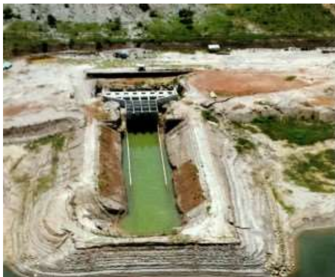
Obras da captação do Sistema Produtor Corumbá, em Luziânia. Foto: Saneago
