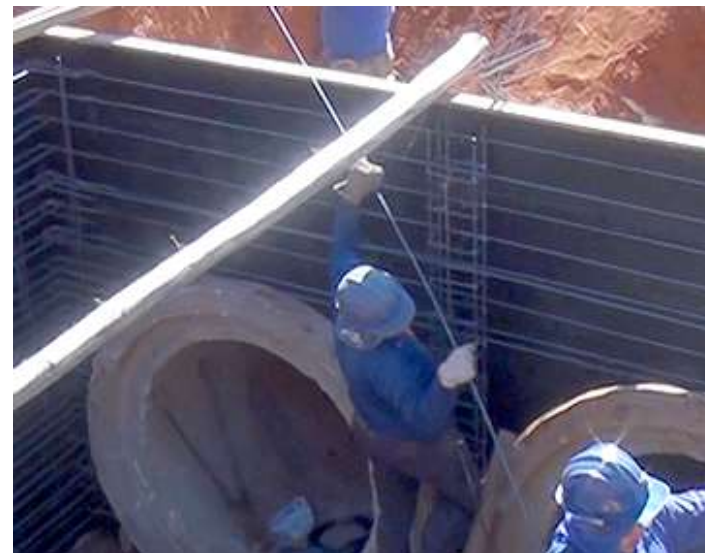
Obras de infraestrutura urbana http://www.luziania.go.gov.br
