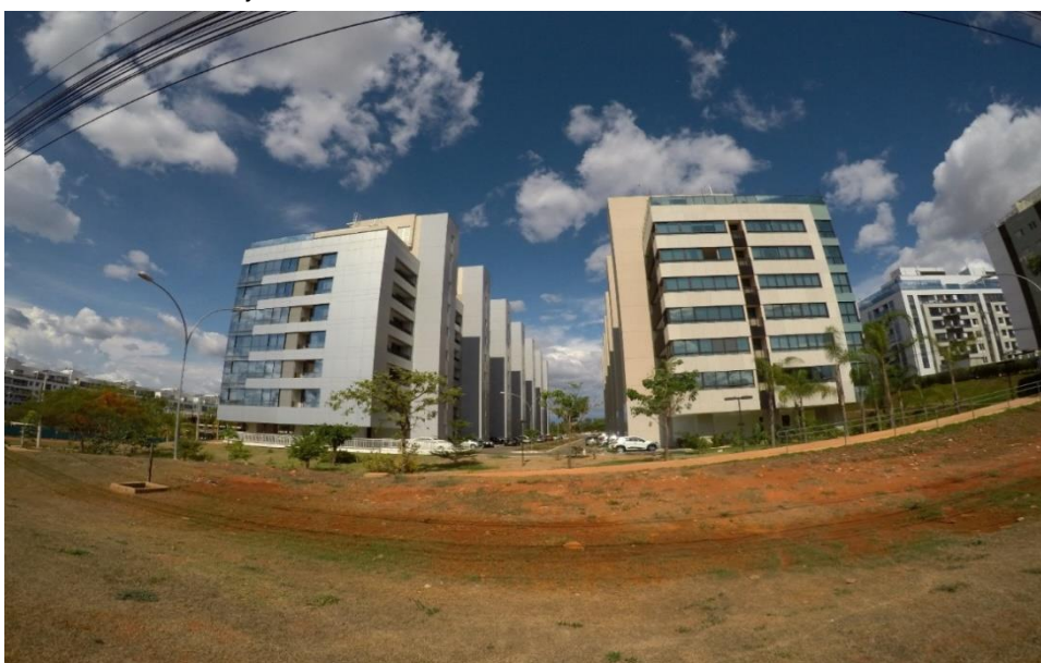
Figura 23 - Prédios localizados sobre cemitério indígena (esquerda) e sobre uma nascente (direita) - Santuário dos Pajés - DF
