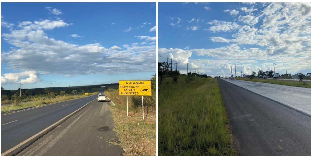
Figura 22 - Paisagem existente na ZPEC
