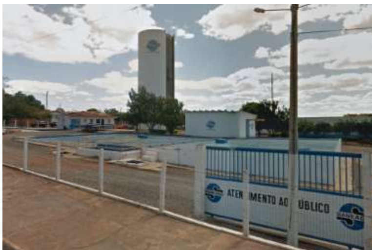
Reservatório de Água SANEAGO – Formosa Fonte: Google Maps
