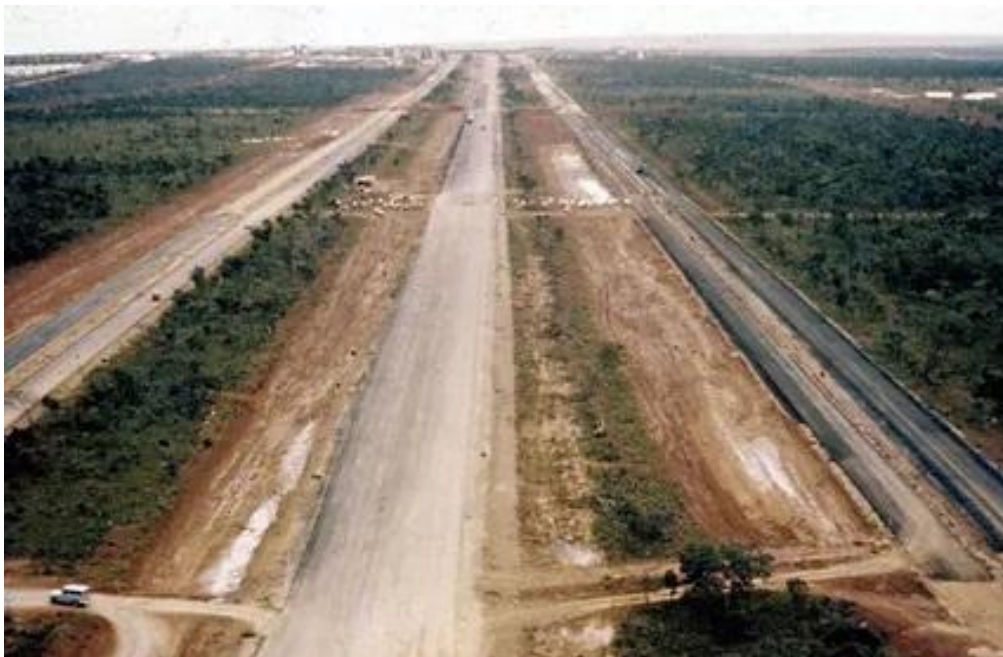
Figura 2 - Construção do Eixão
